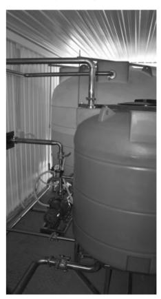
водоподготовки. При наполнении ёмкостей система водоподготовки отключается. В процессе раздачи питьевой воды уровень жидкости в ёмкостях понижается, и когда он достигает среднего уровня, система водоочистки включается и вновь происходит заполнение ёмкостей.
