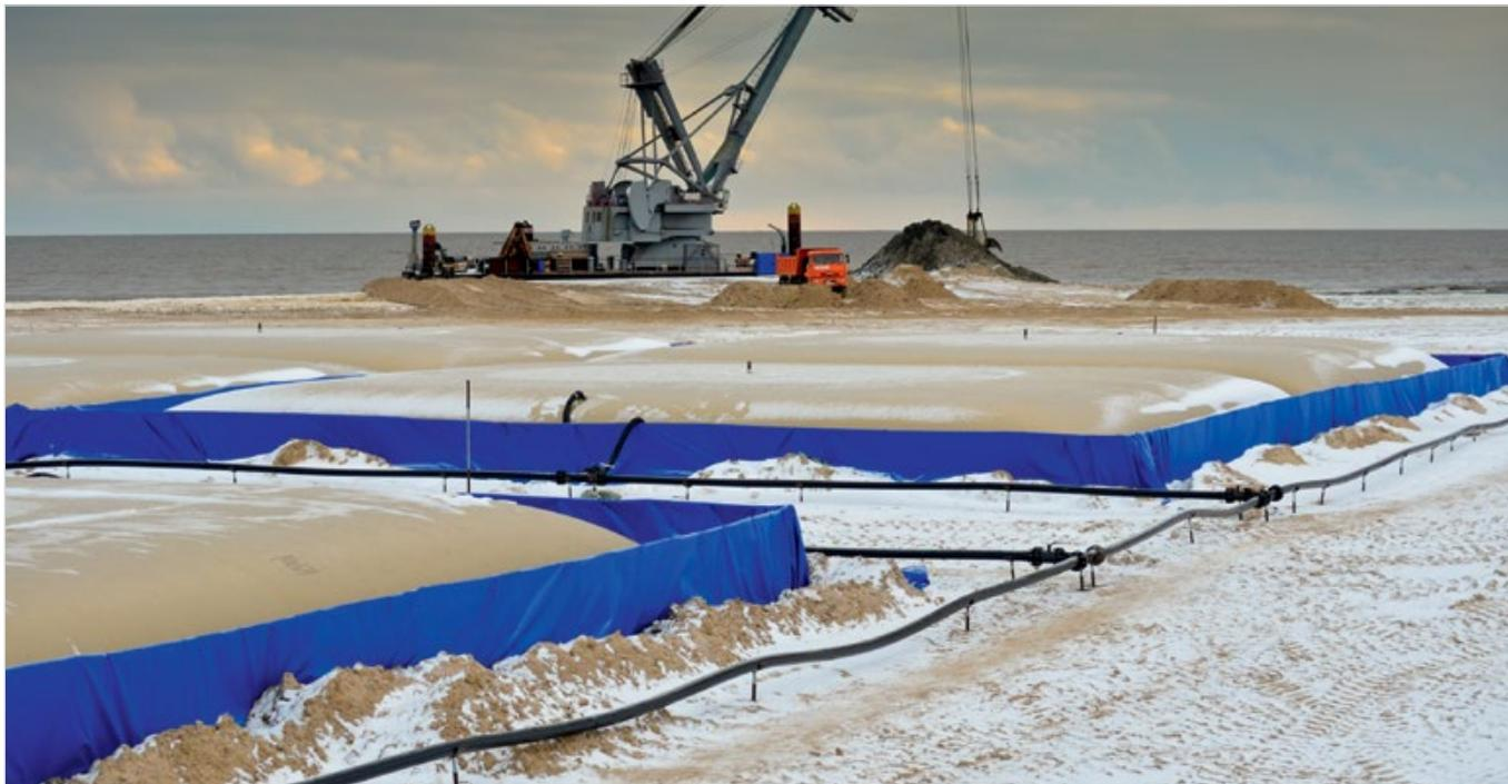
Рис. 4 — Полимерный эластичный резервуар
