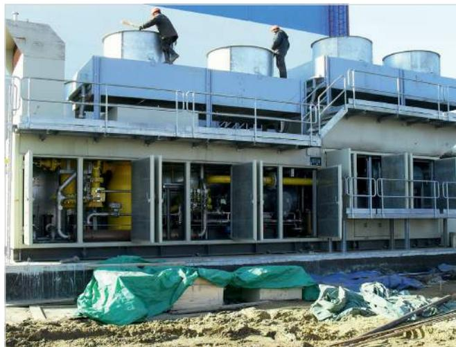
Фото 6 — Монтаж аппарата воздушного охлаждения на компрессорную установку
