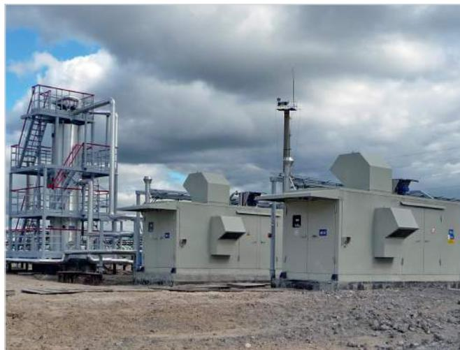
Фото 2 — Компрессорные установки низкого давления на ЦППН НГДУ «Комсомольскнефть»
