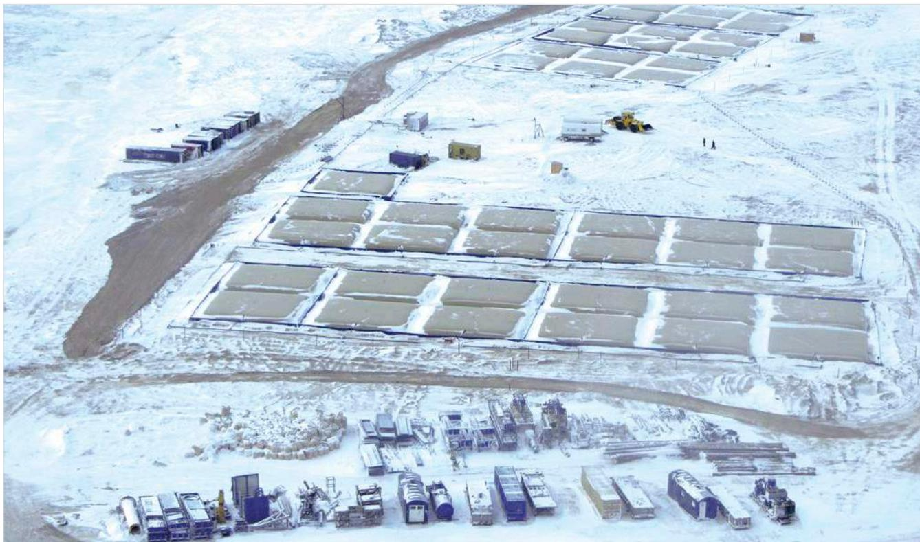
совершенна. Для производства резервуаров использовалась нитрильная резина. Поэтому они обладали целым рядом недостатков: большим весом, относительно малой прочностью, высокой диффузией (150 гр/м<sup>2</sup>/сутки) и серьезными температурными ограничениями (рабочий диапазон от -30 до +30°C). Все это в известной мере нивелировало преимущества эластичных резервуаров и делало невозможным использование резиновых ПСГ в экстремальных условиях Крайнего Севера.
