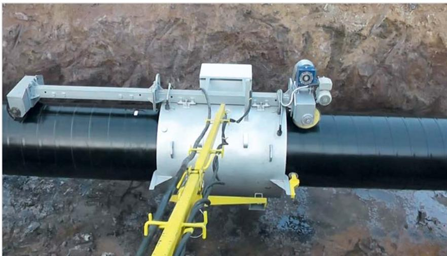
Рис. 4 — Заклучительная операция технологии — термоусадка покрытия «НРЛ-СТ60»
