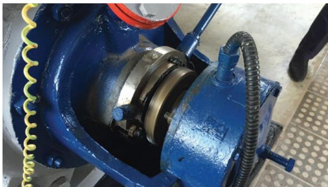
Рис. 2 — Внешний вид торцовых уплотнений
