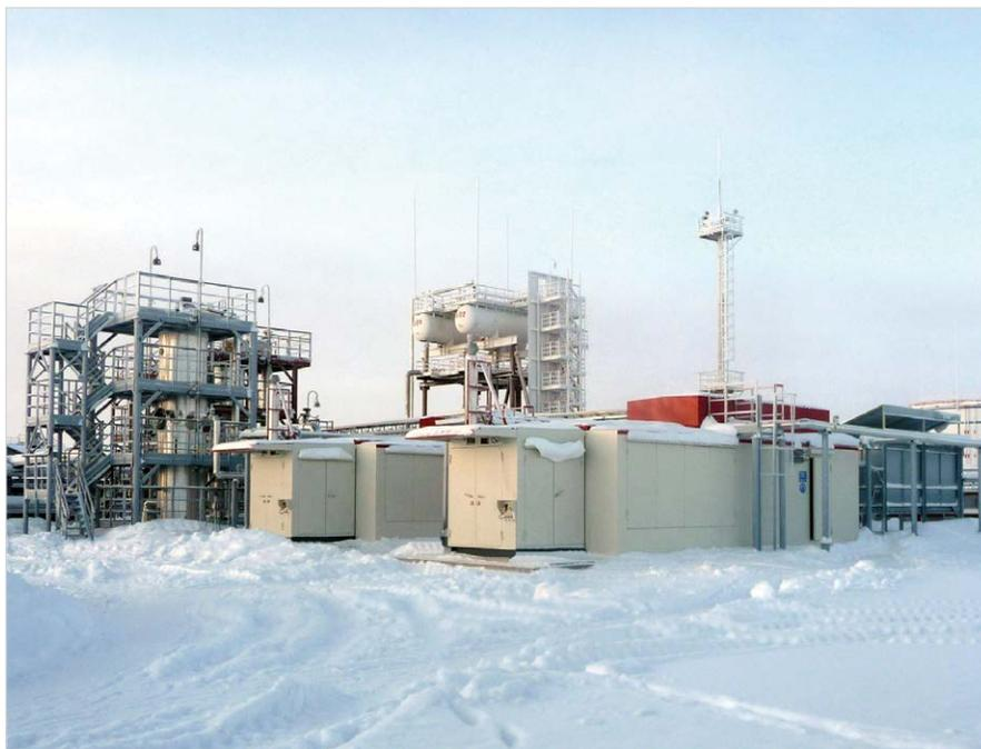
Фото 7 – КУ в арктическом исполнении компримируют НН ПНГ в составе СКНС Северо-Лабатьюганского м/р (Сургутнефтегаз)
