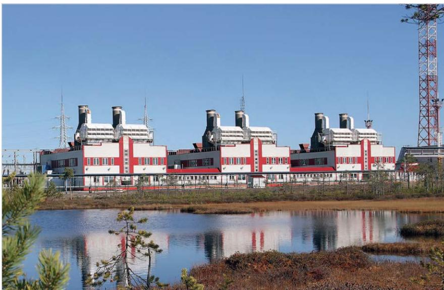
Фото 3 — ГТЭС Ватъеганского месторождения работает на попутном газе
