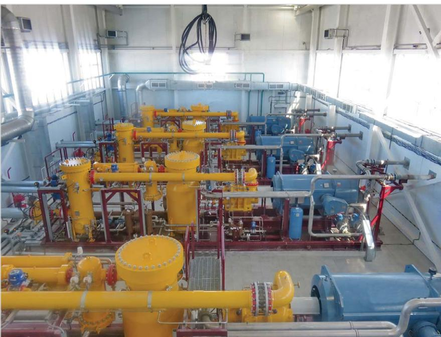
Фото 6 — Компрессорная станция ангарного (внутрицехового) типа для ГТЭС Восточно-Мессояхского месторождения
