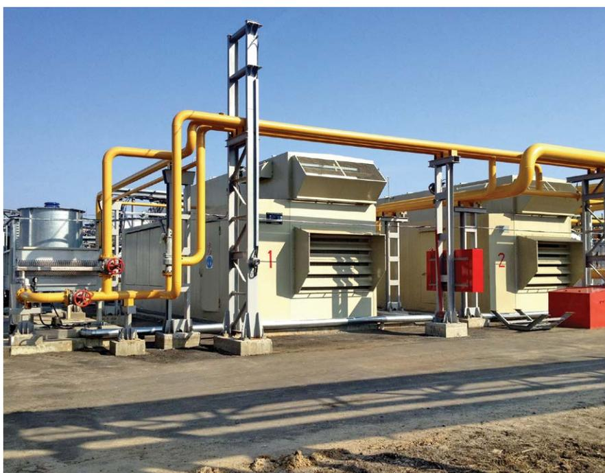
Фото 8 – Оснащение Речицкого месторождения в Беларуси компрессорными установками низкого давления позволило завершить Республиканскую программу по утилизации ПНГ
