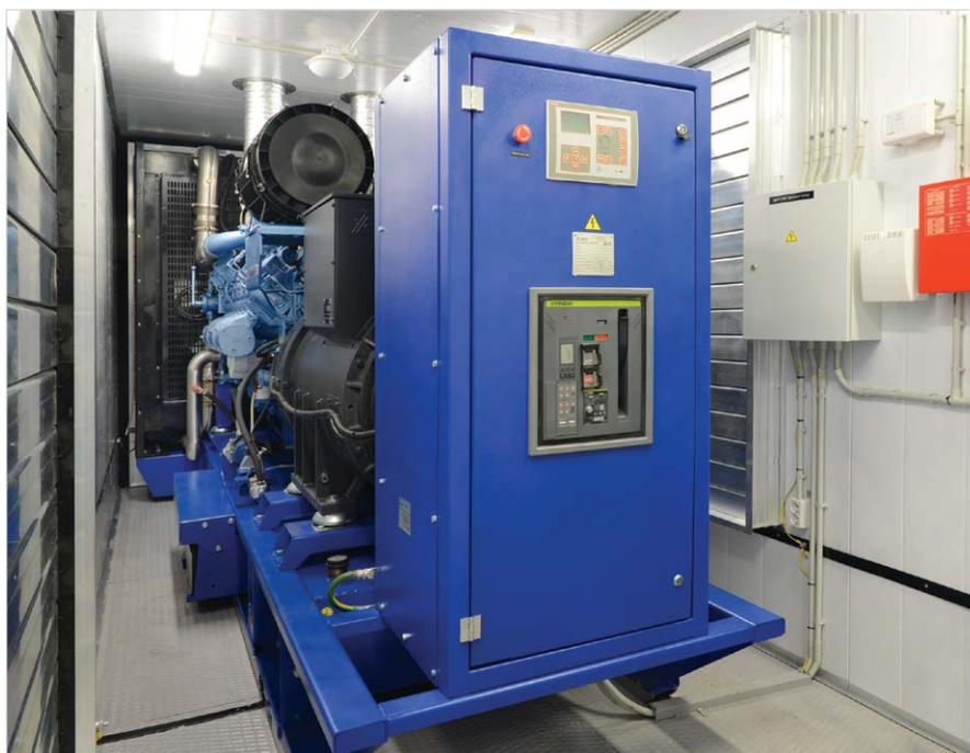
*Фото 2. Дизель-генераторная установка TSS Baudouin 800 кВт в блок-контейнере*
