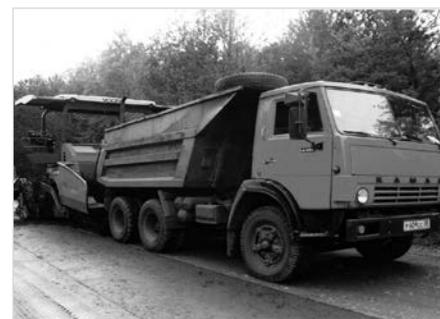
Рис. 3 — Процесс укладки ОМС
